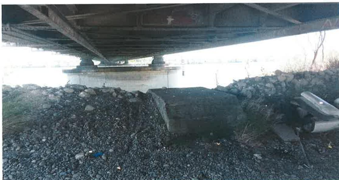
Hauteur du cavalier de digue au pont SNCF : 0.80 mètre (photo de la digue)
